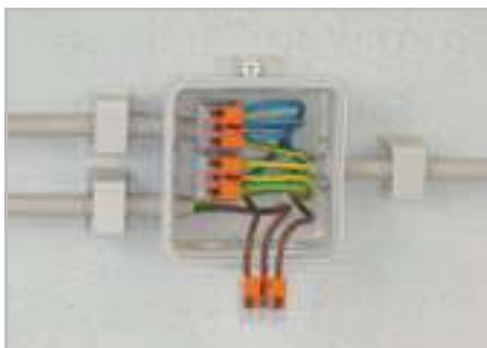
Электромонтаж тонких многожильных проводников в распределительной коробке.
