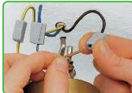
Отключение: нажать кнопку и извлечь проводник.
